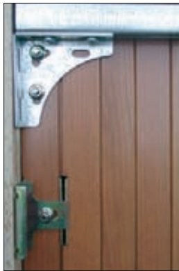
Tapées incorporées (intérieur et extérieur)
