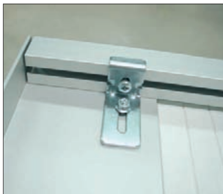
Détail liaison barre de battue haute/tapée cornière
